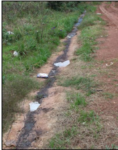
**Figura 10.2-XXXVIII: Canaleta de drenagem após a trincheira**
